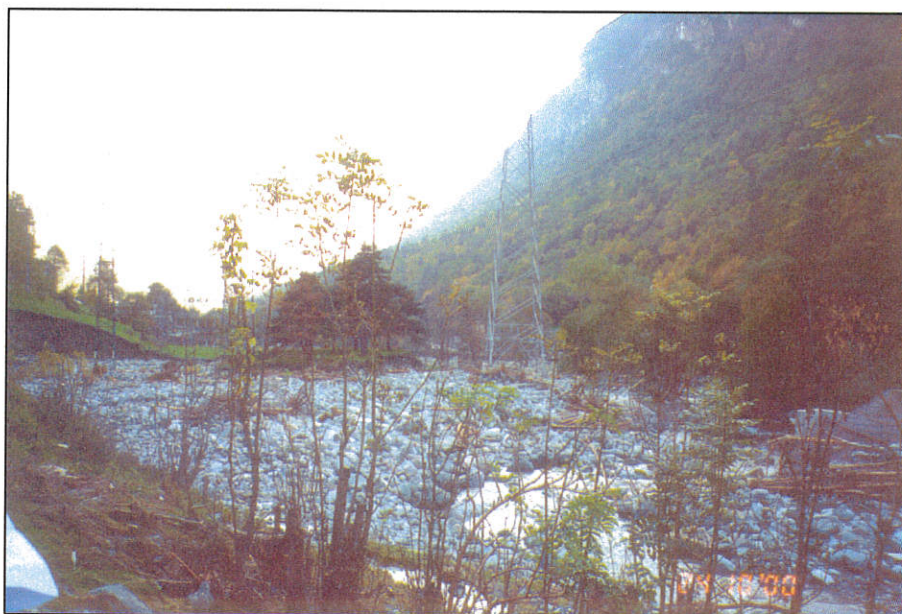
Foto 4 Settore immediatamente a monte dell'impianto di trasformazione situato in prossimità della centrale di Covaloup.
