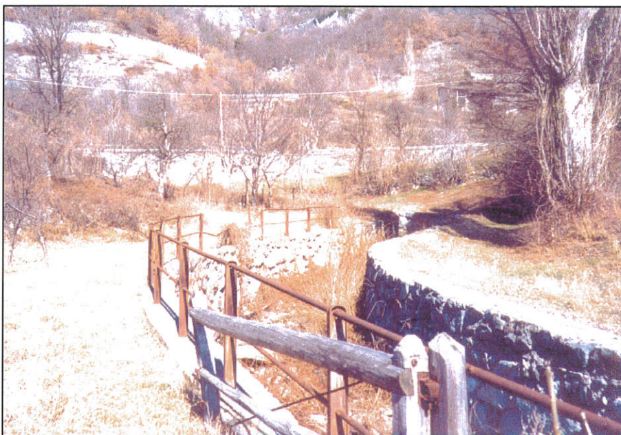
Foto 28 Cunettone in pietra e malta nei pressi della Tour de Néran
