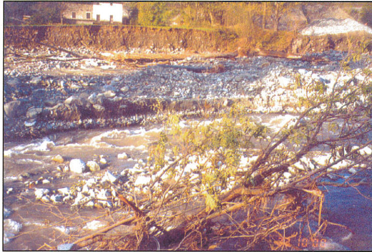
Foto 12 Evidenti forme di erosione e di deposito grossolano sulla destra orografica del conoide immediatamente a monte del ponte ferroviario.
