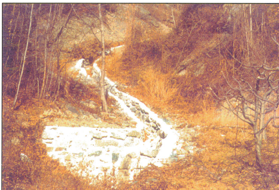
Foto 21 Canale in pietra e malta nel tratto a monte della strada interpoderale di Closet-Dessous
