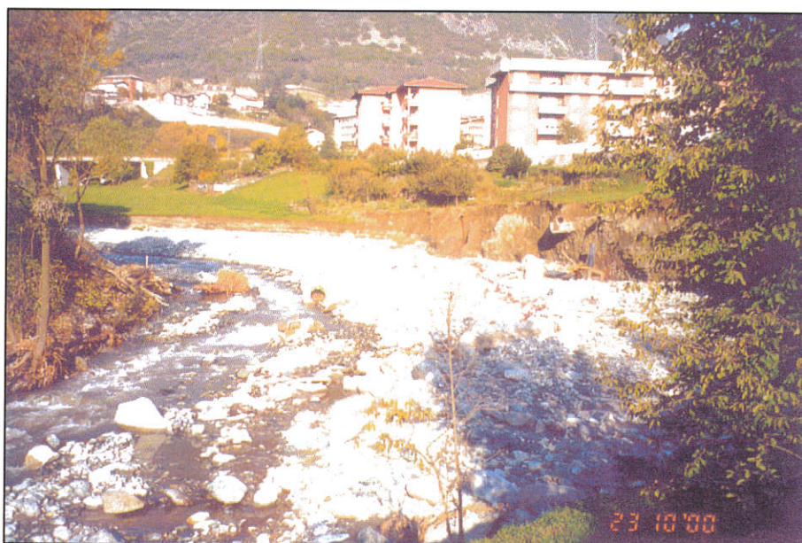
Foto 6 Fenomeni di erosione e di deposito in conoide
