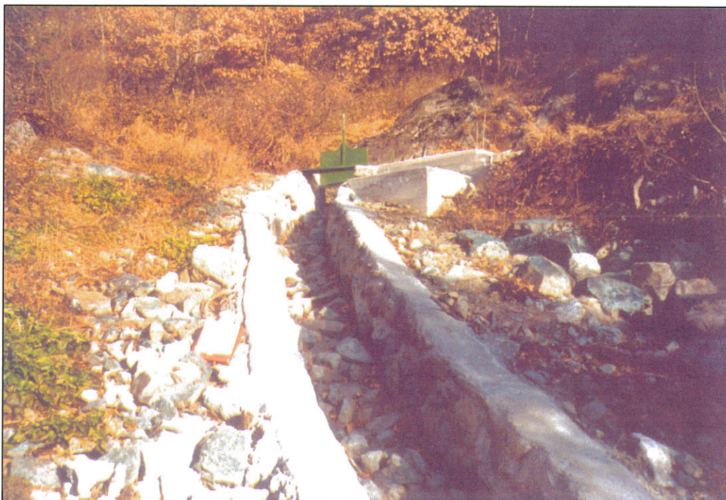
Foto 20 Arginatura in pietra e malta a valle del Ru Gagneur
