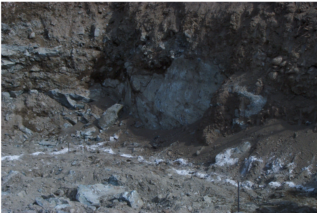
Particolare del blocco : La fratturazione durante la demolizione ne evidenzia i caratteri litologici-serpentinite
