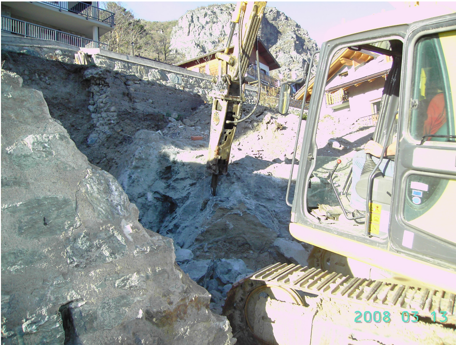
Fase di demolizione
