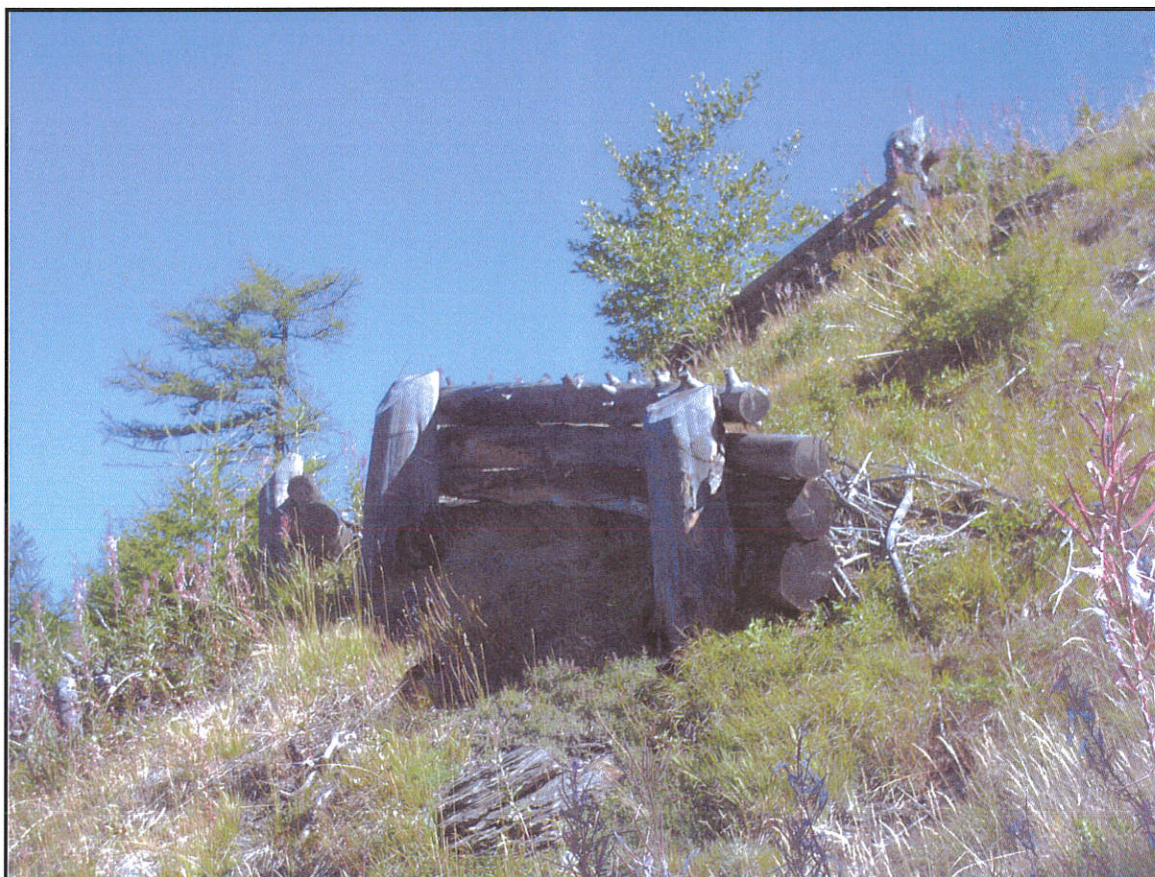
Ponte da neve realizzata in tronchi di Larice: i tronchi sono stati ricavati da esemplari abbattuti in seguito all'incendio che ha colpito il Bois de Cheney (Foto: estate 2003).
