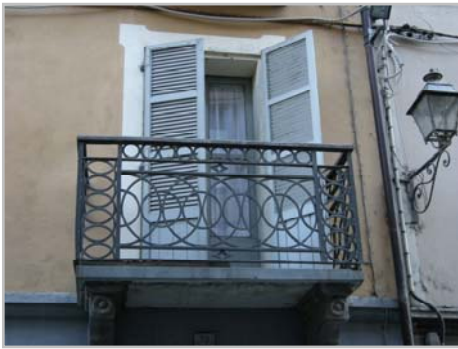
Particolare del balcone in pietra con ringhiera in ferro; porta-finestra con cornice a orecchio e serramento in legno
