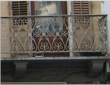
Particolare del balcone con ringhiera in ferro (prospetto su Piazza Duc)
