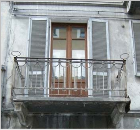
Particolare dei balconi con ringhiere in ferro
