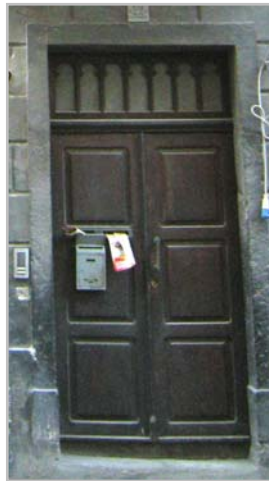
Portone in legno con sopraluce in vetro e cornice in pietra
