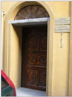
Porta in legno con voltino in pietra e sopra luce in ferro
