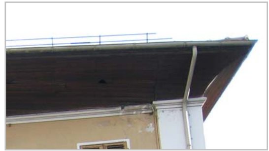
Particolare del cornicione ligneo (prospetto su Piazza Duc)
