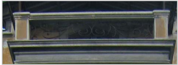
Particolare del balcone a P4 con ringhiera in ferro a motivo liberty
