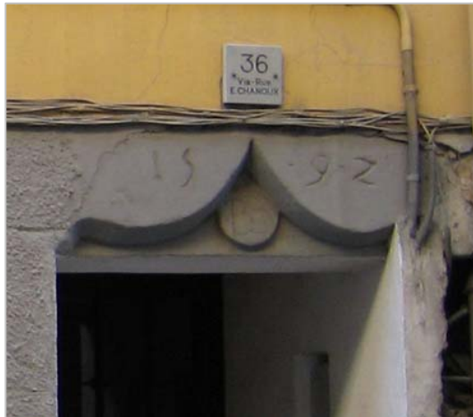
Particolare della porta-finestra con serramento in legno e ringhiera in ferro
