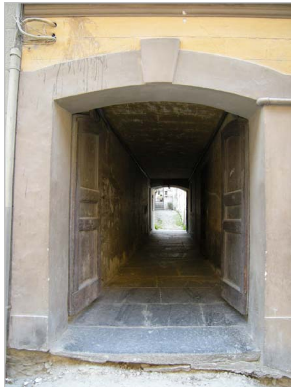
Passaggio coperto con portone in legno, cornice e coniglio in chiave
