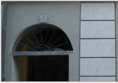
Particolare del voltino in pietra con soprauce in ferro
