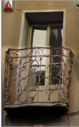
Balcone in cls armato con ringhiera in ferro decorata
