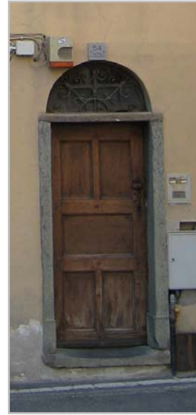
Particolare del portoncino in legno con portale in pietra e sopraluce in ferro decorato
