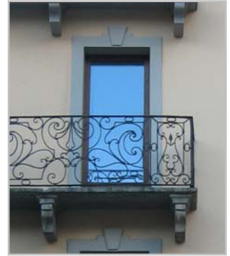
Balcone in pietra con ringhiera lavorata in ferro e cornice con concio in chiave
