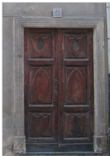
Portone in legno lavorato con portale in pietra modanato e stipiti in rilievo
