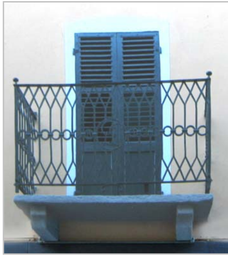
Particolare del balcone in pietra e delle ringhiere in ferro
