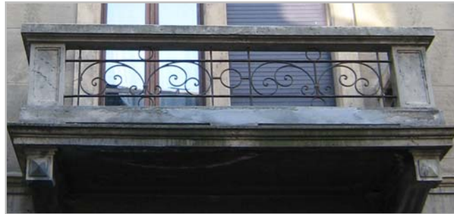
Balcone in cls armato con ringhiera decorata a elementi in ferro in stile liberty
