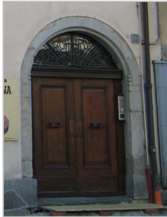
Portone in legno con sopraluce in ferro
