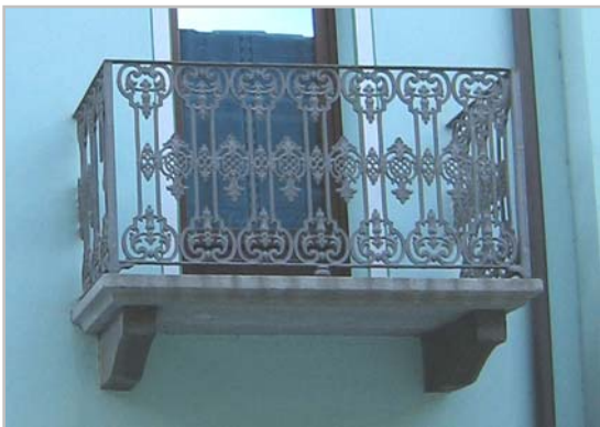
Balcone e ringhiera in ghisa lavorata
