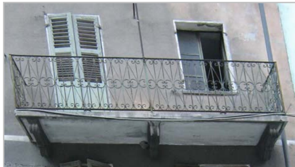
Balcone con modiglioni in cls armato e ringhiera in ferro
