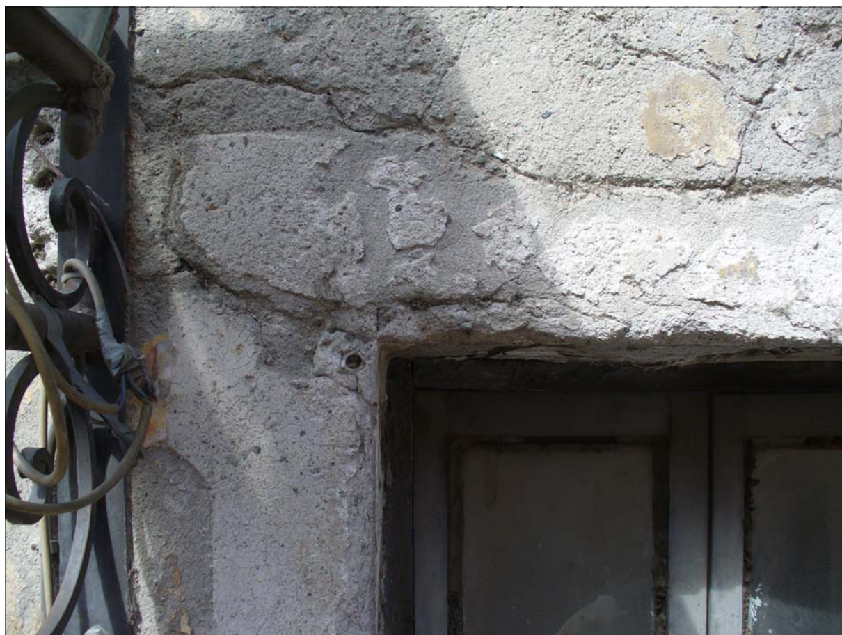
Foto 1 Particolare della finestra con cornice a rilievo lisciata tipo marmorino .
