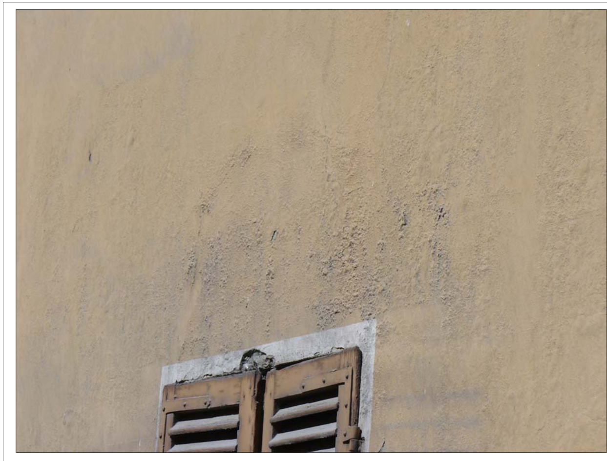
Foto 1 Cornice della finestra visibile sotto lo strato di tinteggiatura superficiale.
