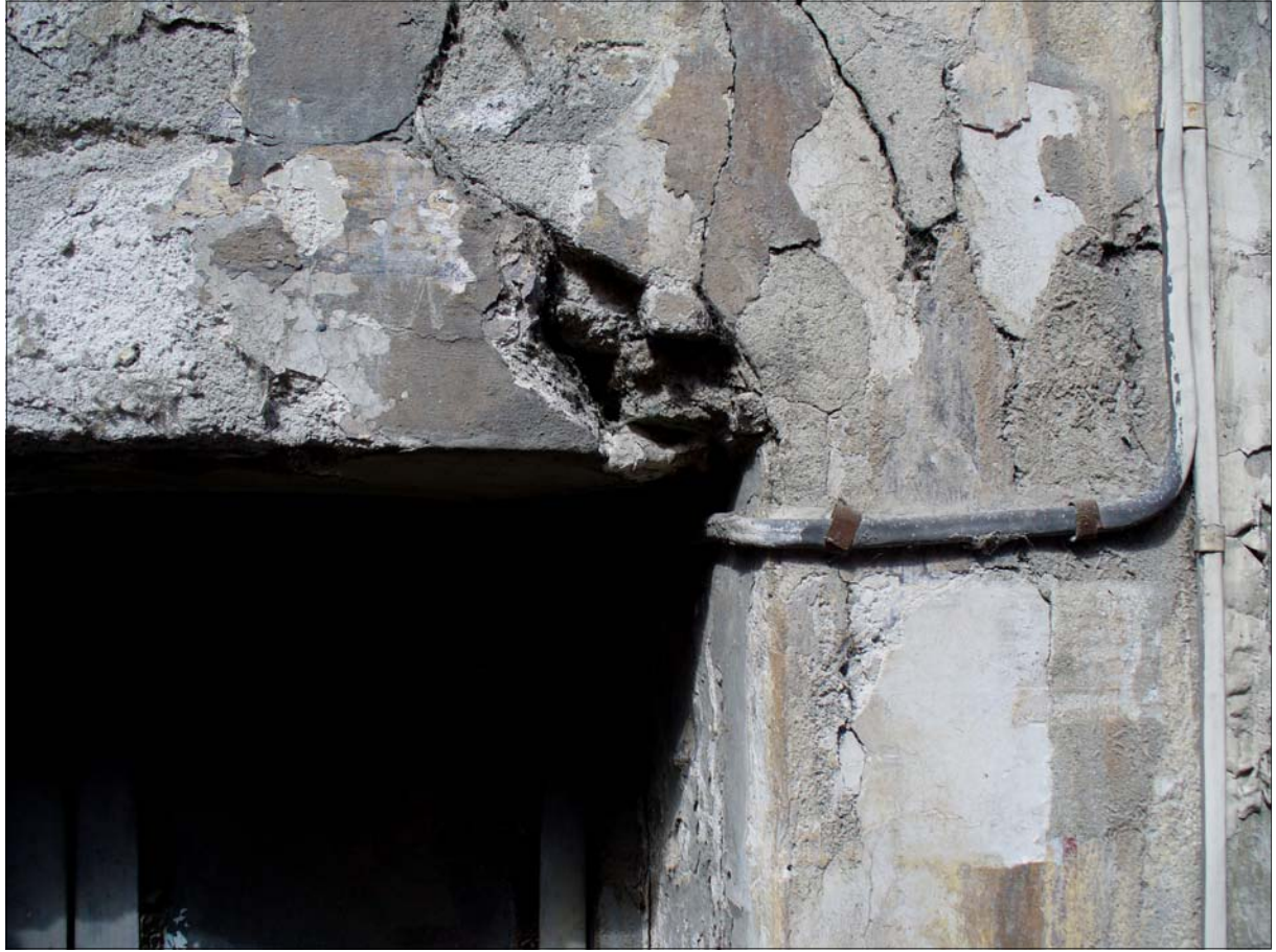
Foto 2 Particolare della finestra con cornice a rilievo liscia tipo marmorino .
