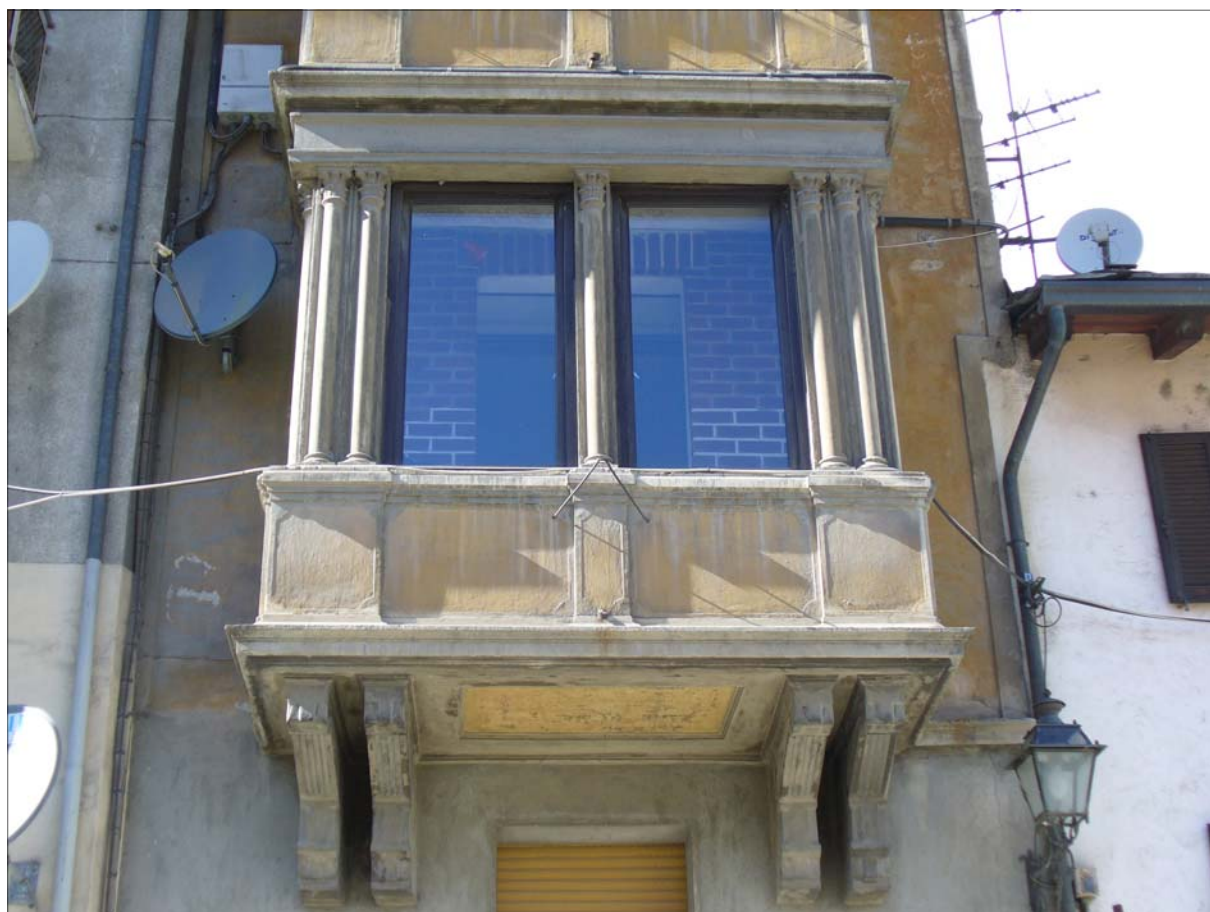
Foto 1 Particolare della facciata. Nella parte superiore si evidenzia il rapporto cromatico coevo all'epoca di costruzione.
