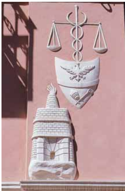
▼ Gli stucchi che decorano la facciata dell'ex palazzo Gervasone
