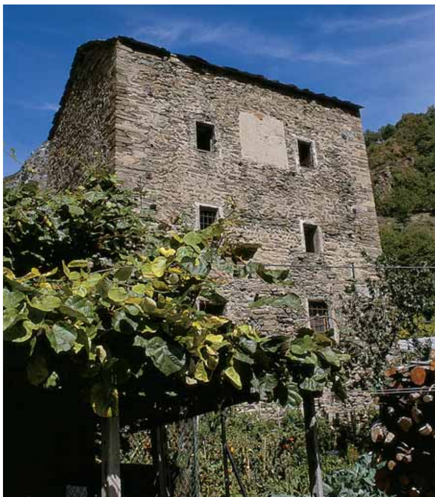
▲ La torre posta a nord dell'abitato di Conoz
