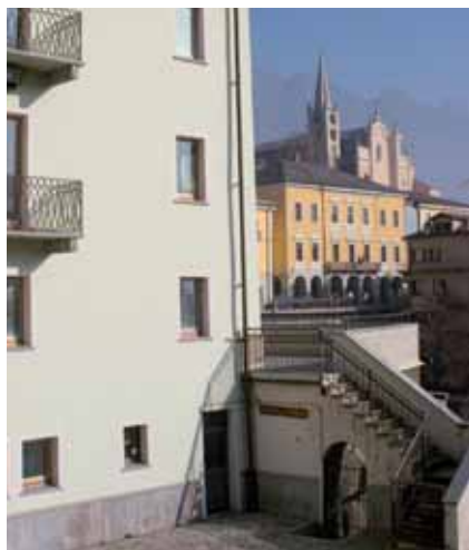
▲ Casa Conte Luda con l'ingresso della Crotte des Vignérans
